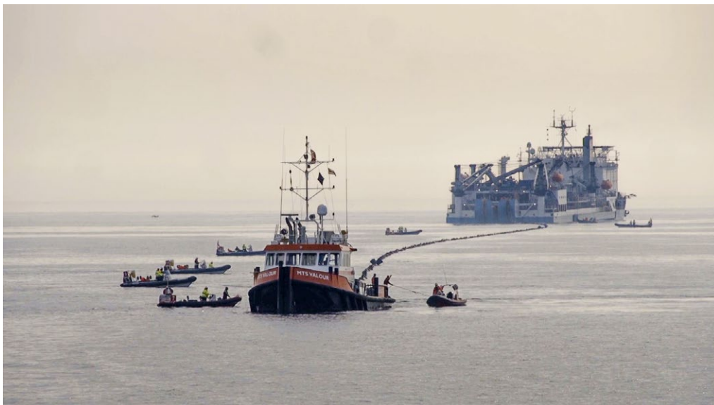
Den 720 km lange undersjøiske strømkabelen mellom Suldal i Rogaland og Blyth i England blir lagt på bunnen av Nordsjøen
