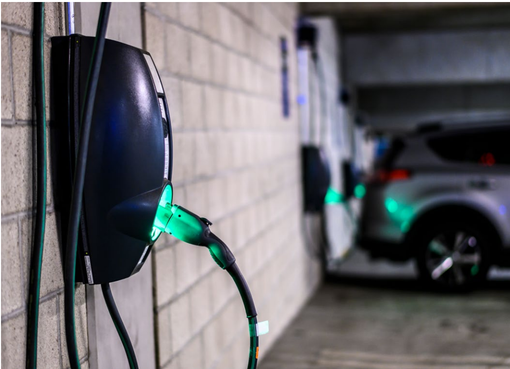
En ny rapport fra RISE Fire Research fastslår at det ikke er større behov for sprinkleranlegg i parkeringsgarasjer med elbil-lading, enn i andre parkeringsgarasjer
