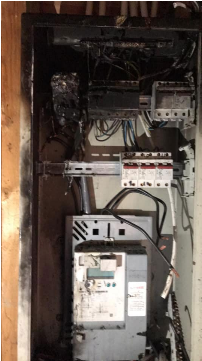
UTBRENT. Alt i sikringsskapet var ødelagt etter brannen
