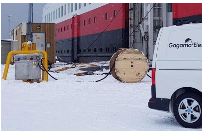
LANDSTRØM. Gagama har koblet to Hurtigruteskip i opplag til landstrøm i Hammerfest havn
