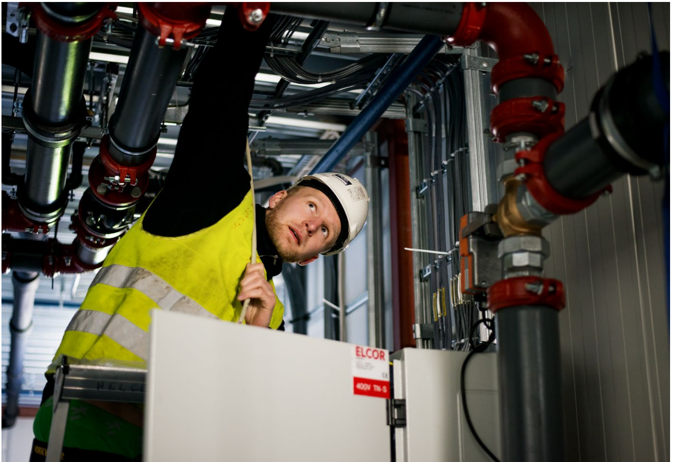
NYANSETTELSE. Ingeniør Ivar Pettersen i Drammen har ansatt et par nye montører etter at myndighetene innførte koronatiltak. Selskapet har heller ikke stoppet inntaket av lærlinger
