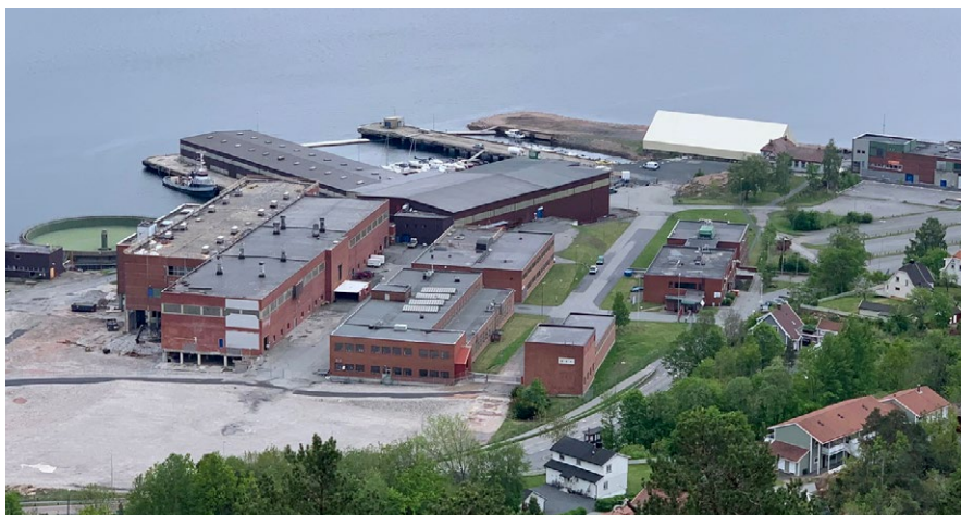
Silva Green Fuel sitt demonstrasjonsanlegg på Tofte bygges i eksisterende bygningsmasse
