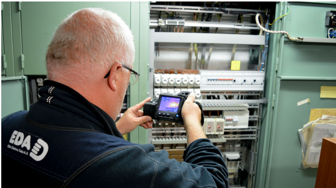
TI KONTROLLØRER. - Vi har ti ansatte som kun arbeider med internkontroll hos våre kunder. Her er termografering et viktig element, sier prosjektleder Lars-Åke Frøhaug i EDA
