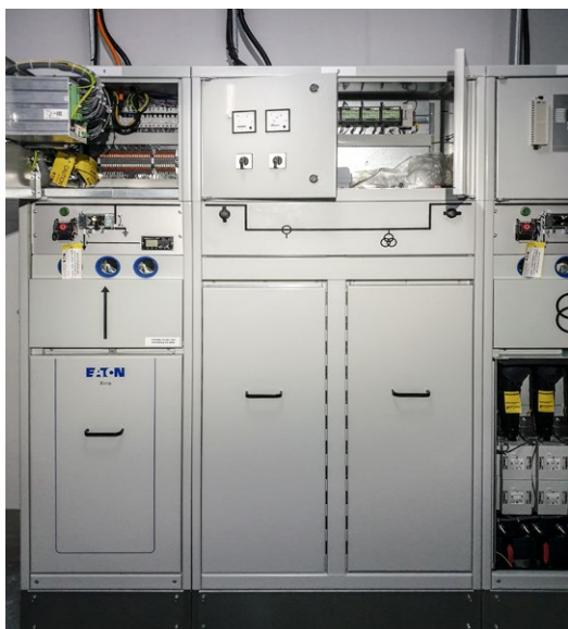
Høyspentanlegget Xiria fra Eaton bruker vakuumbrytere for å håndtere lysbuer i Ulriken tunnel i Bergen
