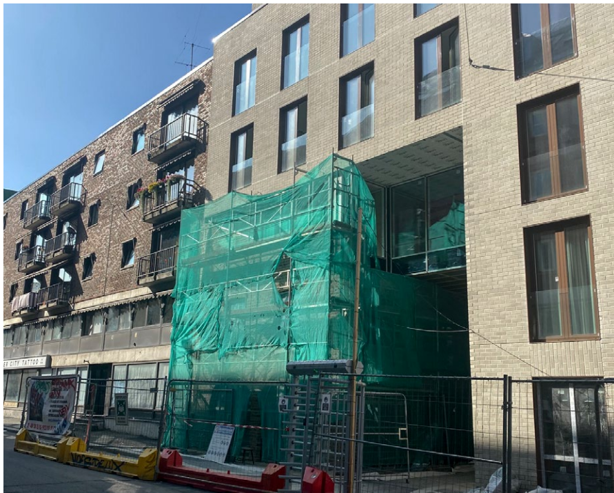
UREGISTRERT VIRKSOMHET INSTALLERTE. En elkontroll i Mariboegate 14 i Oslo utløste et omfattende tilsyn i byggeprosjektet Mariboegate 14 + 16 der både Plan- og bygningsetaten i Oslo kommune, A-krimgruppen i Oslo, Det lokale eltilsyn, Politiet og Arbeidstilsynet deltok. Resultatet ble stenging av seks elanlegg, umiddelbar stopp i arbeidene og tilbaketrekking av brukstillatelsen
