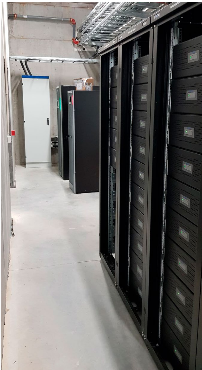
434 KWH. Batteripakken fra Eaton har en kapasitet på 434 kilowattimer. Den både lagrer og styrer solstrømmen
