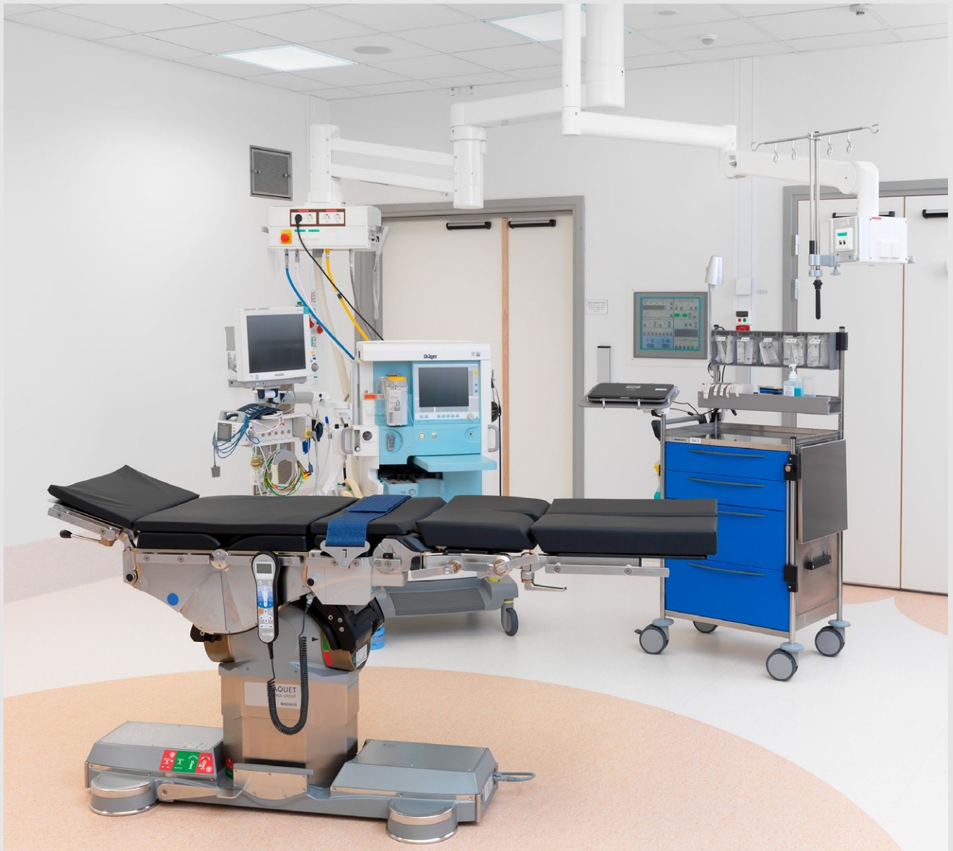
OPERASJONSBELYSNING. Fagerhult skal blant annet levere belysning til operasjonsstuene på det nye sykehuset i Stavanger. Her stilles det spesielt strenge krav
