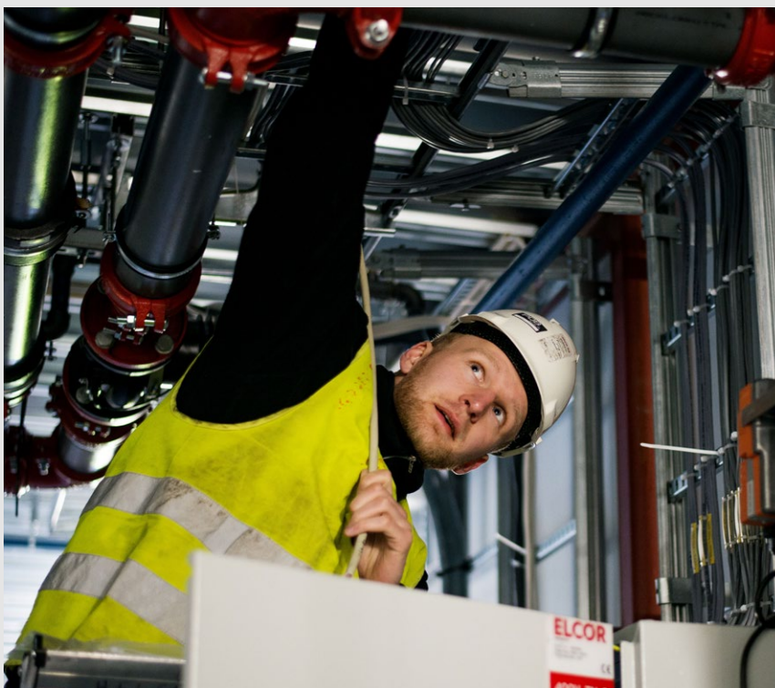
FLERE ANSATTE. I koronaperioden har Ingeniør Ivar Pettersen ansatt et par nye montører og tatt inn lærlinger som planlagt
