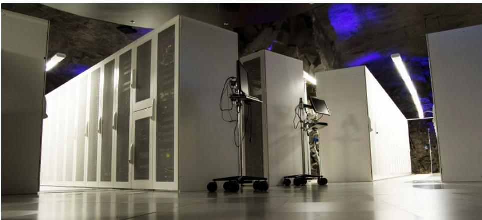
Fredrik Aandal, produksjef for UPS-systemer i Eaton Norge, tror UPS-anlegg i stadig større grad vil samspille med kraftnettet
