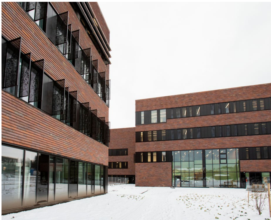
ABSOLUTT TETT. Dyresykehuset på Campus Ås (bildet over og t.h.) på 63 000 m 2 har landets strengeste krav til smittevernløsninger
