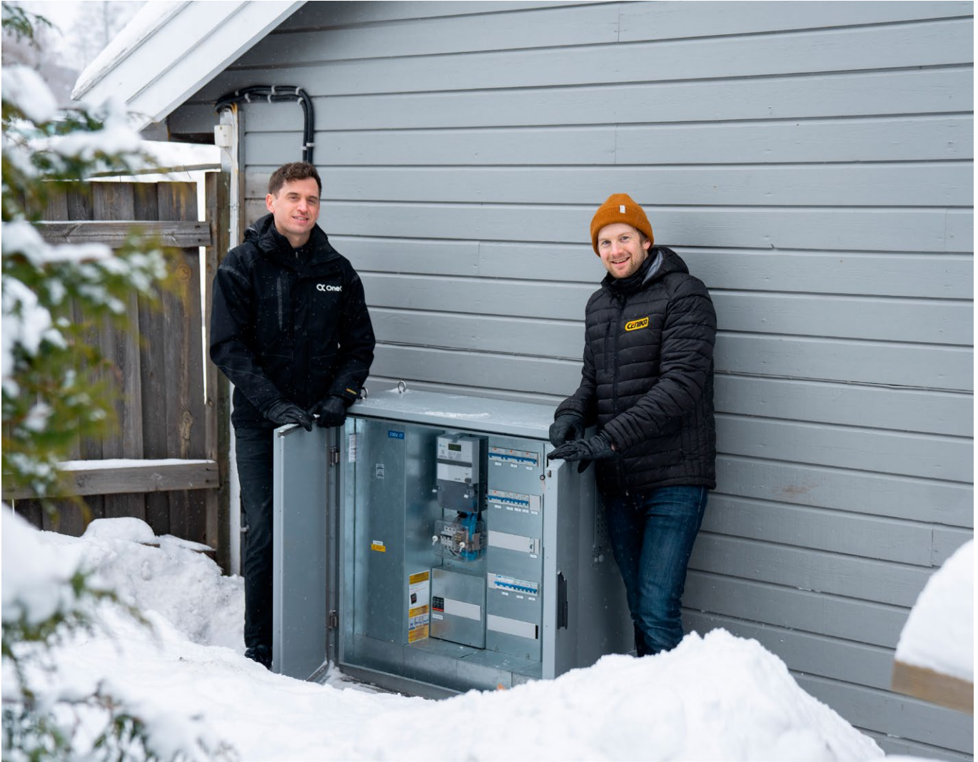
ELBILLADING. Petter Fuglem (t.v.), prosjektleder service i OneCo Elektro sin avdeling i Oslo, og selger Glenn Jørgensen i Cenika foran OutFlex-skapet som er installert for elbillading på Hovelsrudgrenda garasjesameie på Fjellhamar utenfor Oslo
