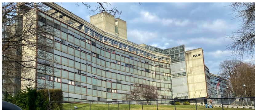
Politihuset på Grønland i Oslo skal rehabiliteres
