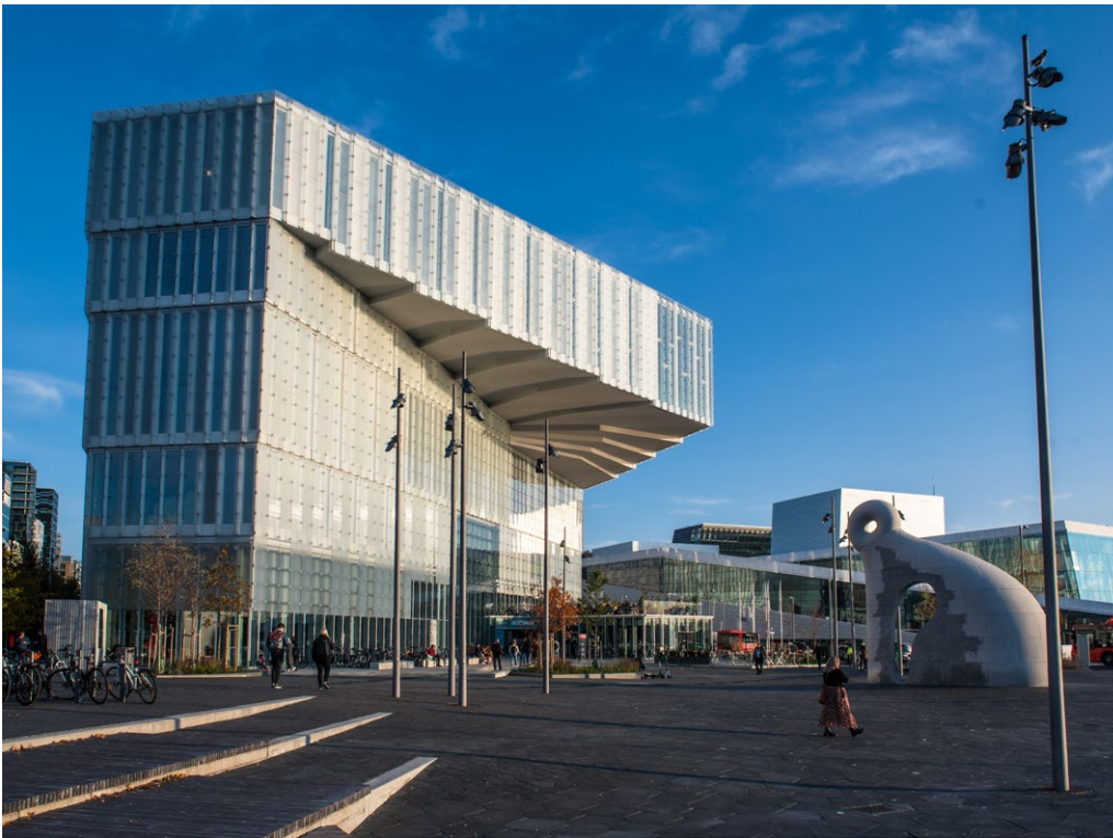
BÆREKRAFTBYGG. Til nye Deichmanske bibliotek i Oslo har GK levert behovsstyrt ventilasjon, automatisering og SD-anlegg
