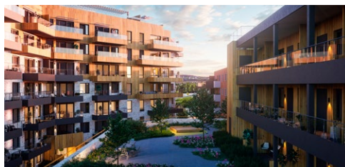
De nye leilighetene Peab bygger for Fredensborg Bolig skal være ferdig om drøyt to år
