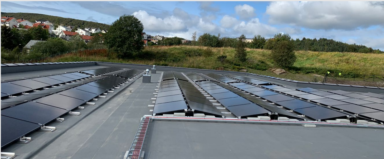
70 000 KWH. På Mørkvedbukta skole og barnehage har Elektro Bodø installert et solcelleanlegg på 589 m 2 , med en beregnet årlig produksjon på inntil 70 000 kWh
