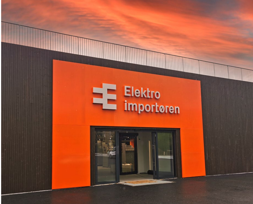
24 VAREHUS. Fra Tromsø i nord til Kristiansand i sør har Elektroimportøren 24 varehus. Bildet viser varehuset på Jessheim
