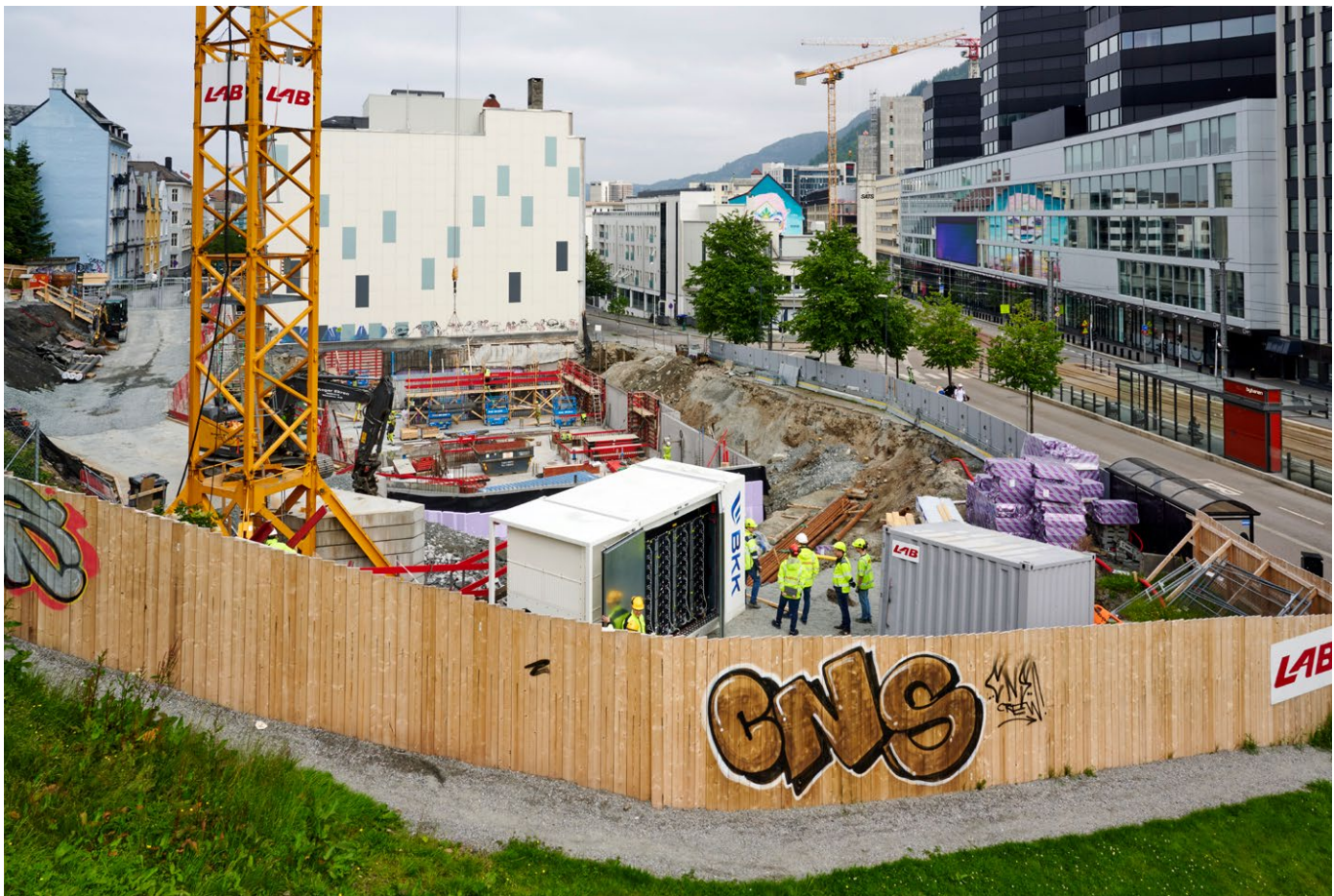
SIKRER NOK STRØM. På en tomt i Nygårdsgaten i Bergen bygger LAB Entreprenør et 12 000 m 2 stort kontorbygg. Her sikrer et batteri med en kapasitet på 500 kilowattimer at det er nok strøm
