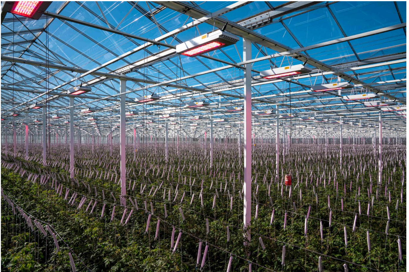
OPTIMALISERT BELYSNING. Miljøgartneriet på Nærbø i Rogaland har det største drivhuset i Norge på 70 000 m 2 . Her er det installert belysning som skal bidra til å optimalisere produksjonen
