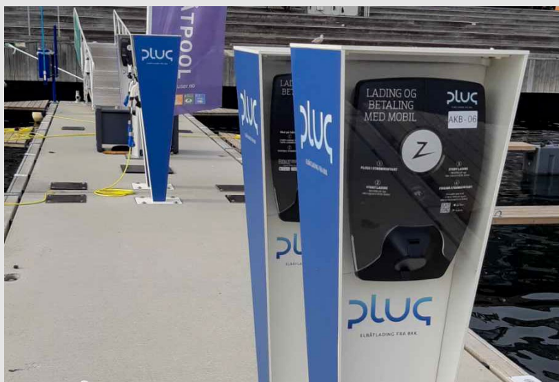
ELBÅT-LADING. BKK har blant annet installert elbåt-ladere på Aker Brygge i Oslo
