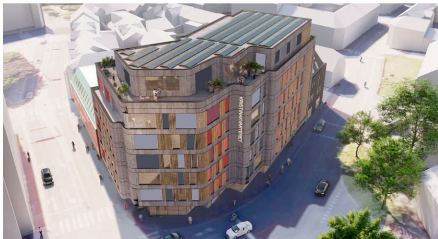
Kristinakvarteret i Tønsberg skal totalrenoveres med blant annet solceller på taket
