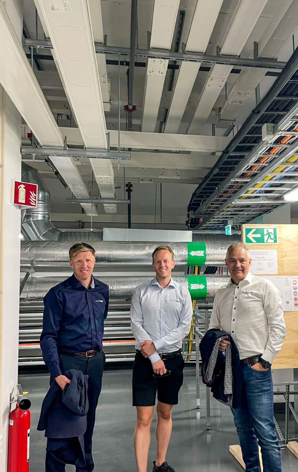
FEM KM MED STRØMSKINNER. Kjetil Kaldestad (t.v.), VP Home e- Distribution e- Power Products, Geir-Arne Erikstad, Regional Sales Manager og Torstein Grøtteland, Sales Engineer og Account Manager, i Schneider Electric Norge i Rogaland sjekker Canalis-strømskinnene i Veterinærbygget
