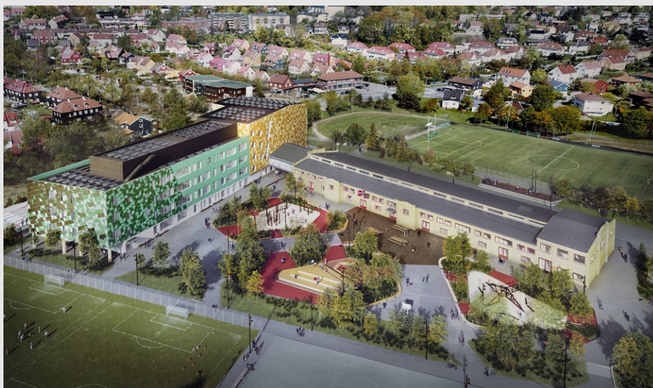
EU-PROSJEKT. Erfaringene fra byggingen av nye Voldsløkka skole skal deles i et EU-prosjekt
