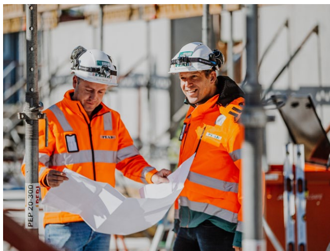
I Tromsø skal Peab Bjørn Bygg oppføre 111 seniorleiligheter med et totalareal på 11 400 m 2
