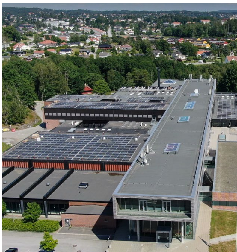
På Høgskolen i Østfold sin avdeling i Halden er det installert 3 000 m 2 med solceller
