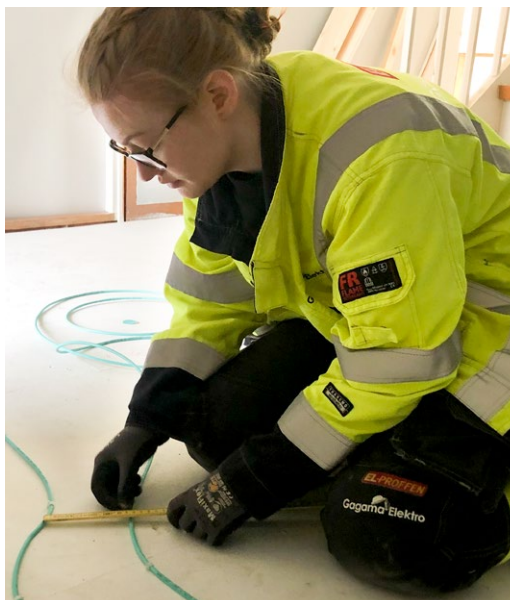
SATSER PÅ KVINNER. Montør Marita Pedersen i Gagama Elektro installerer varmekabel
