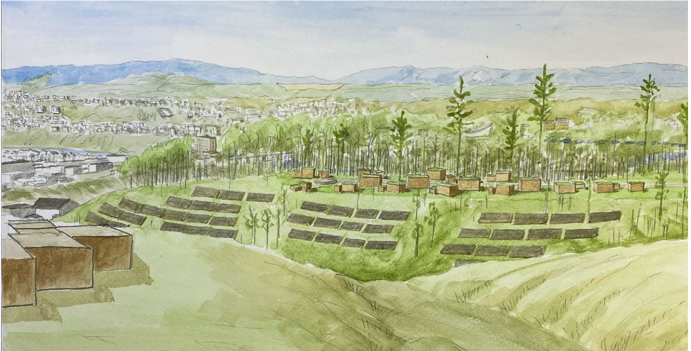
SOLENERGI. Åtte mål med terrengintegreerte bakkemonterte solceller skal gi solenergi til en utslippsfri bygge- og anleggsplass, boliger, hurtigladere, elbiler og fellesområder. Anlegget har en installert effekt på 500 kWp. Energien skal lagres i et batteri med en kapasitet på 1 MWh ILLUSTRASJON: THOMAS KLEVJER
