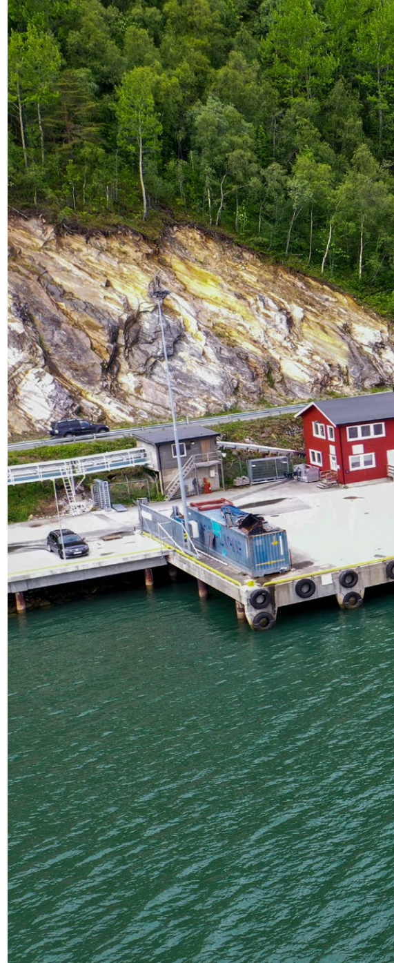
DYPVANNSKAI. Ved dypvannskaia på Rognan skiper Nexans ut
