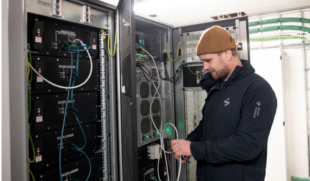
BATTERIINSTALLASJON. Petter Andresen i Eaton i gang med å koble batterier i et teknisk rom
