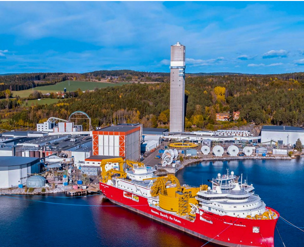
DOBLER KAPASITETEN. Nexans dobler produksjonskapasiteten i Halden. Midt på bildet kabelleggingsskipet Nexans Aurora
