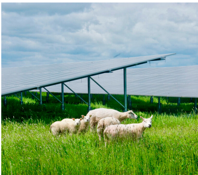
Eidsiva og Energeia skal kombinere solkraftproduksjon og landbruksvirksomhet
