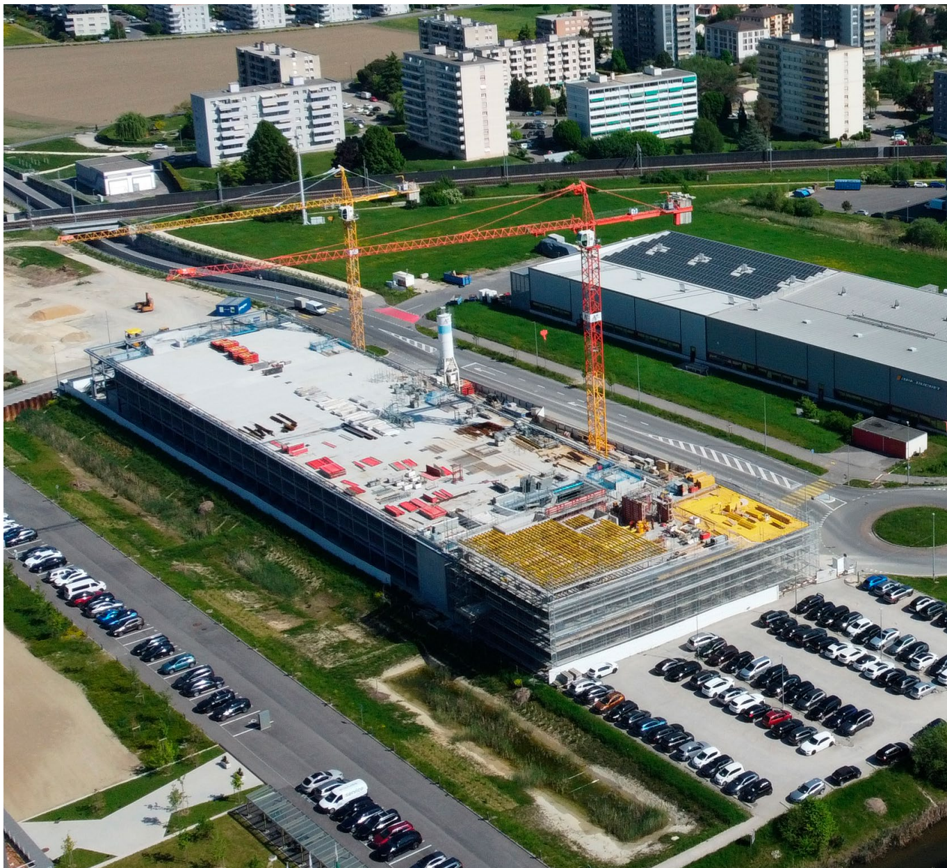
TOVEISBRUK. I industriparken Yparc i Yverdon-les-Bains i Sveits skal 350 elbiler kobles til et lokalt strømnettverk. Anlegget skal være i drift i løpet av 2022
