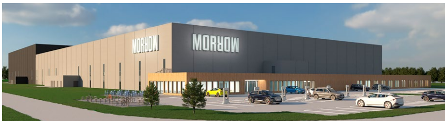
Veidekke er i gang med å bygge batterifabrikk til Morrow Batteries i Arendal
