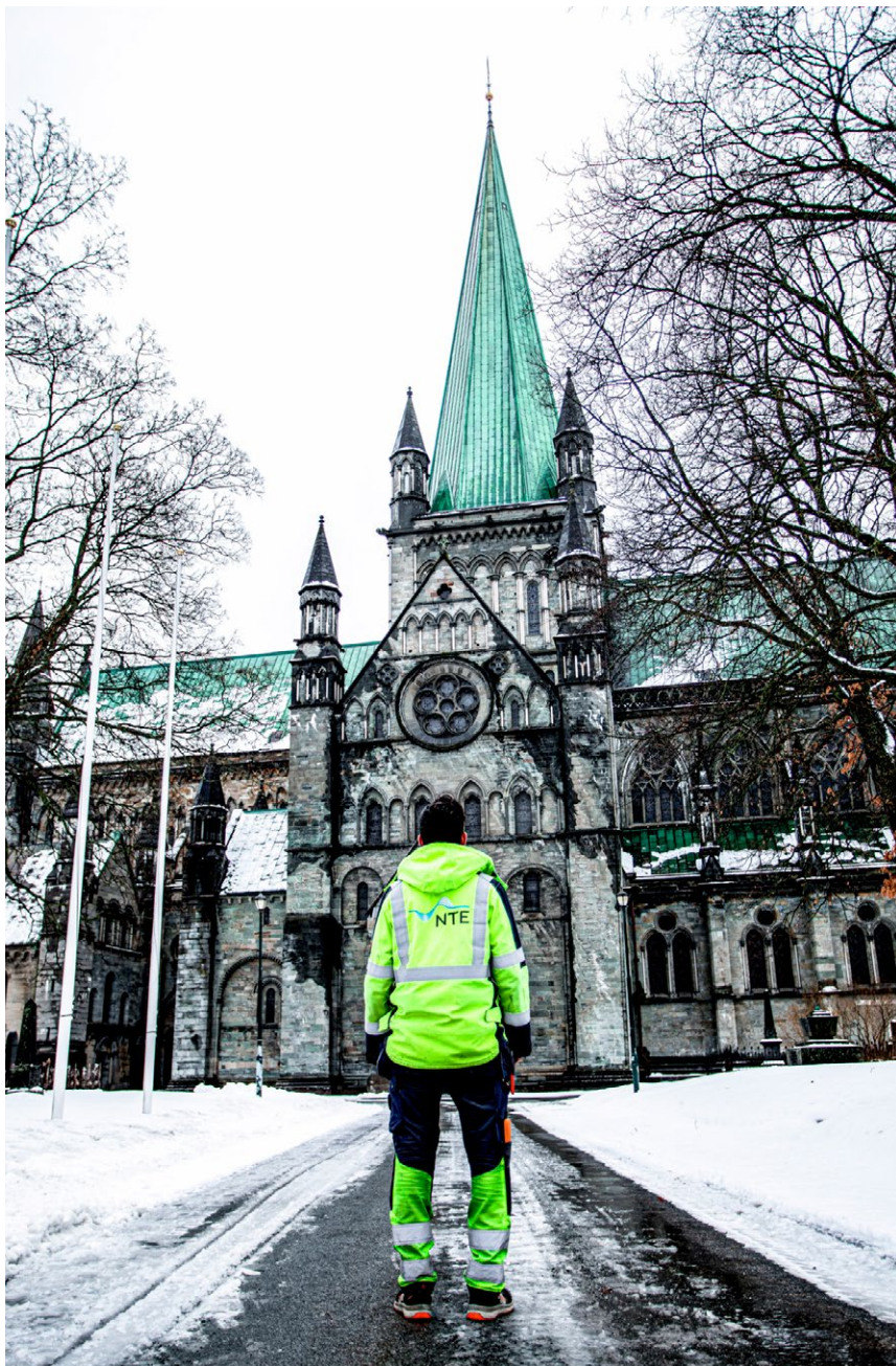
IKKE HVERDAGSKOST. Å installere ny belysning i Nidarosdomen var ikke hverdagskost for elektrikerne i NTE Elektro
