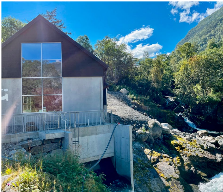
Mork kraftverk skal årlig produsere rundt 42,5 GWh
