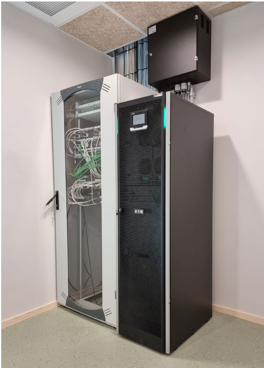
NØDSTRØM. Ved strømbrydd holder UPSen 91PS fra Eaton den nye miljøstasjonen på Svalbard i drift i 1 time
