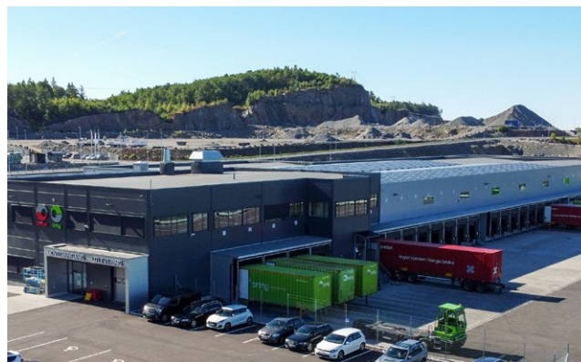
Posten sitt største logistikkenter på Sørlandet har solceller på taket
