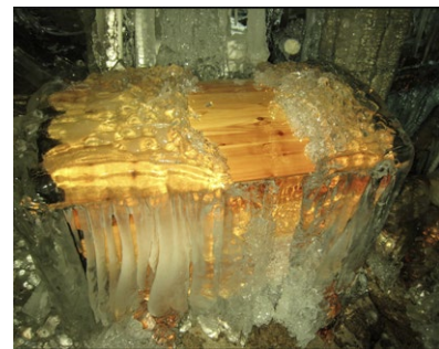
Frost- og vannskader kan være svært omfattende
