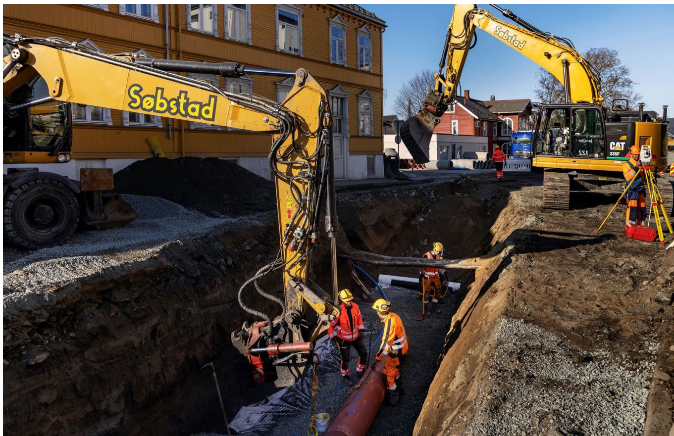
MÅTTE BLI FERDIG. Trondheim kommune og maskinentreprenør Søbstad meglet om spuntarbeid utført på Ladebekken i Trondheim av en underentreprenør til sistnevnte
