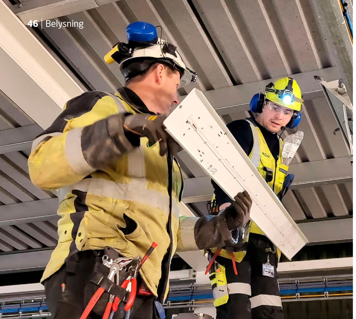
LED-KIT. Med en LED-kit blir lyskilden, elektronikken og optikken i hver armatur byttet, mens selve huset blir gjenbrukt
