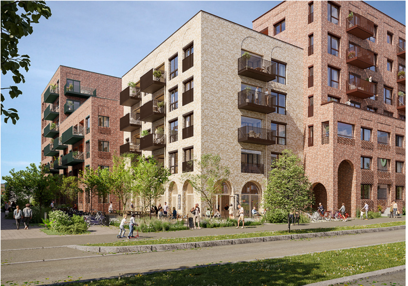
Obos og Skanska starter byggingen av kvartal 4 på Nansenløkka
