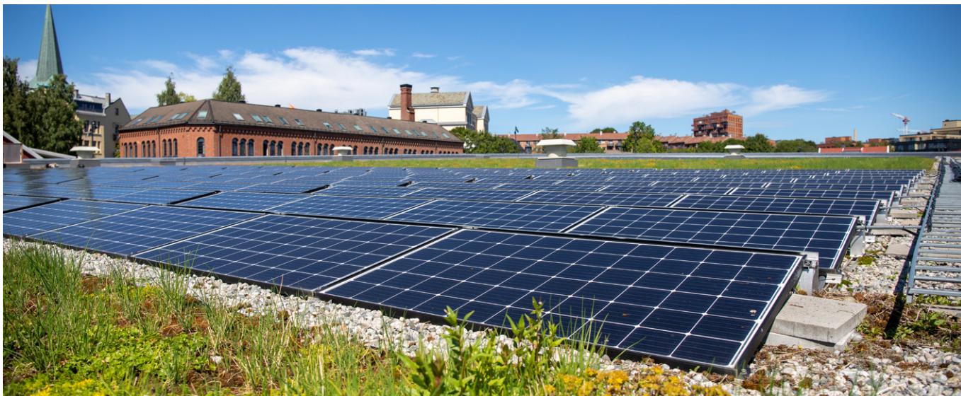
Oslobygg, som forvalter mer enn 2,7 millioner m 2 barnehager, sykehjem, skoler, brannstasjoner og kultur og idrettsanlegg på vegne av Oslo kommune, skal samle data fra eksisterende og fremtidige solcelleanlegg i en skyløsning utviklet av Guard Automation
