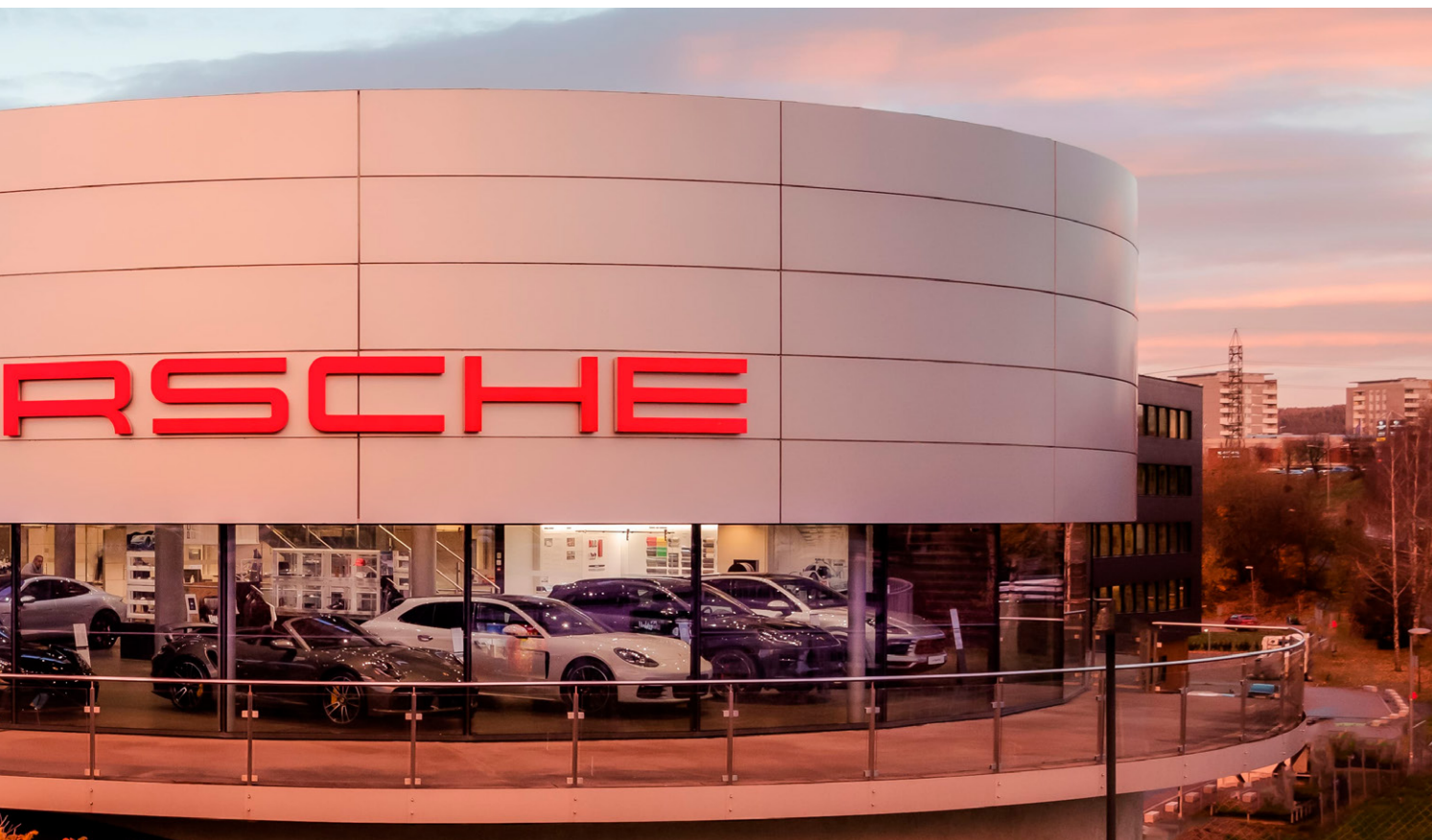
... skal spare selskapet for store og dyre reparasjoner
