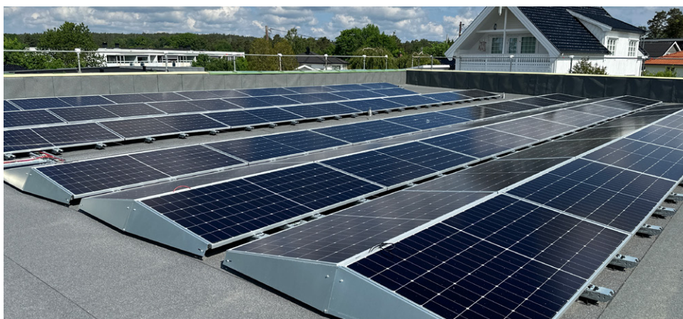
NCC har bygget Halden kommune sitt første plusshus
