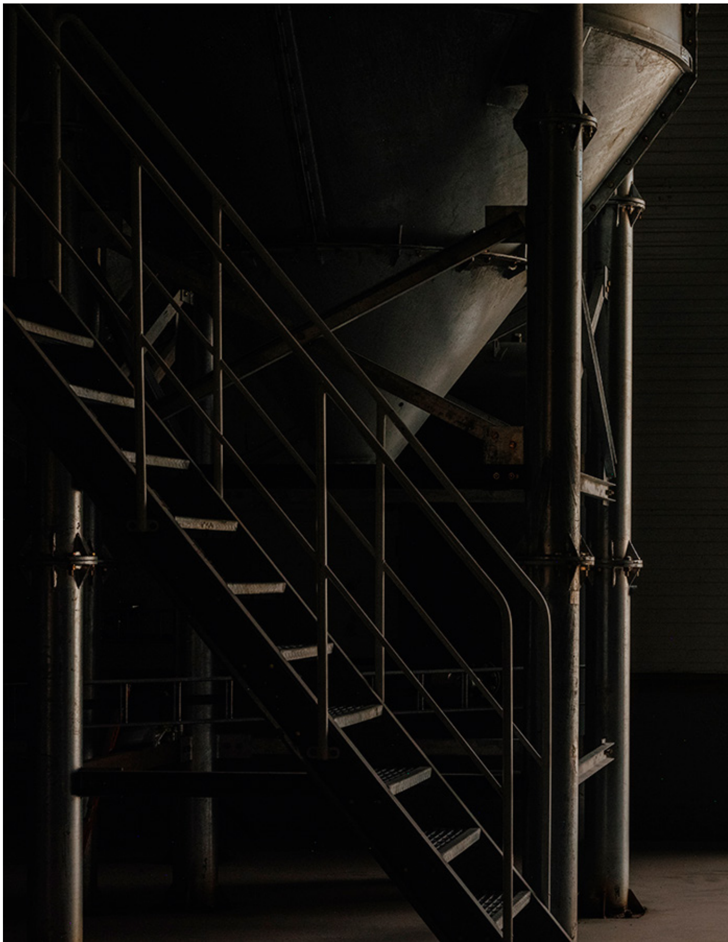
DIGITALISERT. Sement-anlegget i Sandnes er digitalisert og delvis automatisert med systemer for elektrisk distribusjon og industr
