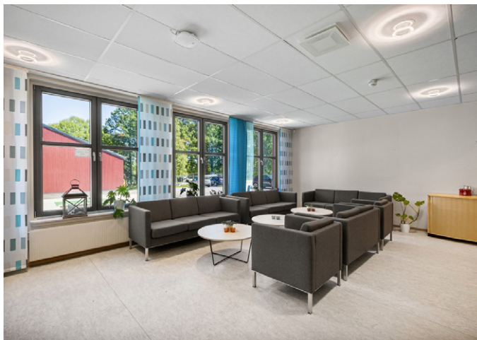
Andebu ungdomsskole i Sandefjord har oppdatert belysningen med LED-armaturer fra Luxia
