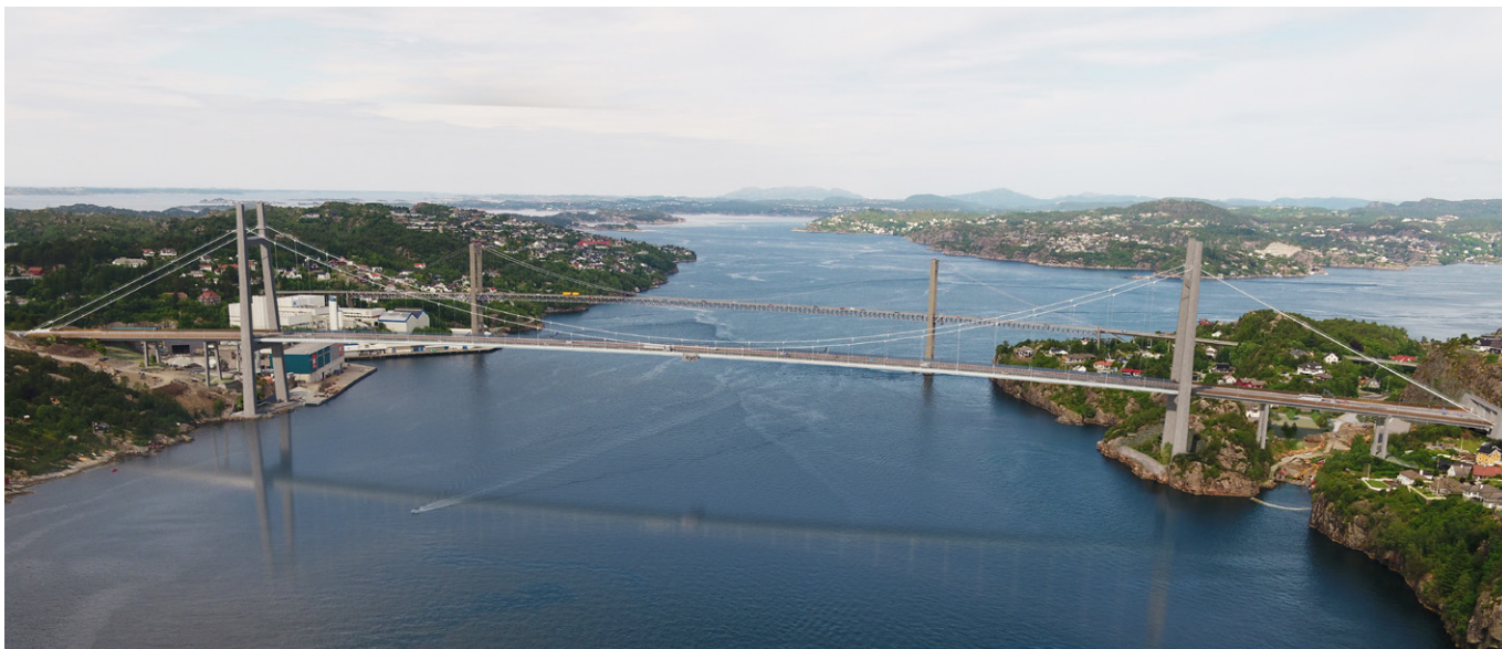
HELDIGITAL. Ny Sotrabru er verdens største heldigitale konstruksjon der alt fra design til utførelse skjer digitalt
