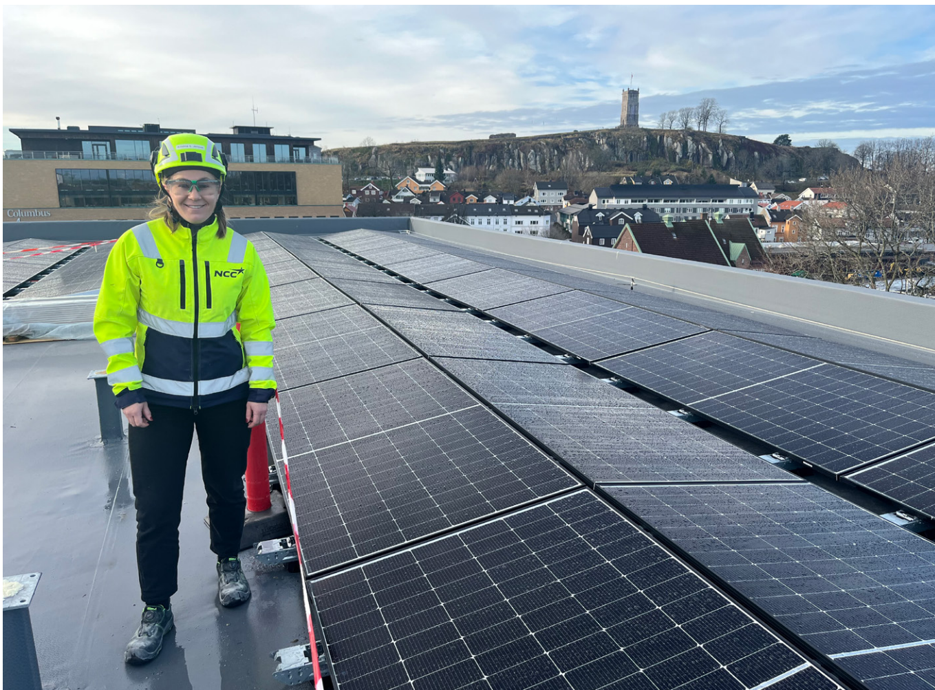
Prosjektingeniør Kristine Skjefeld Jensen i NCC sjekker solcellene på Tønsberg Tinghus
