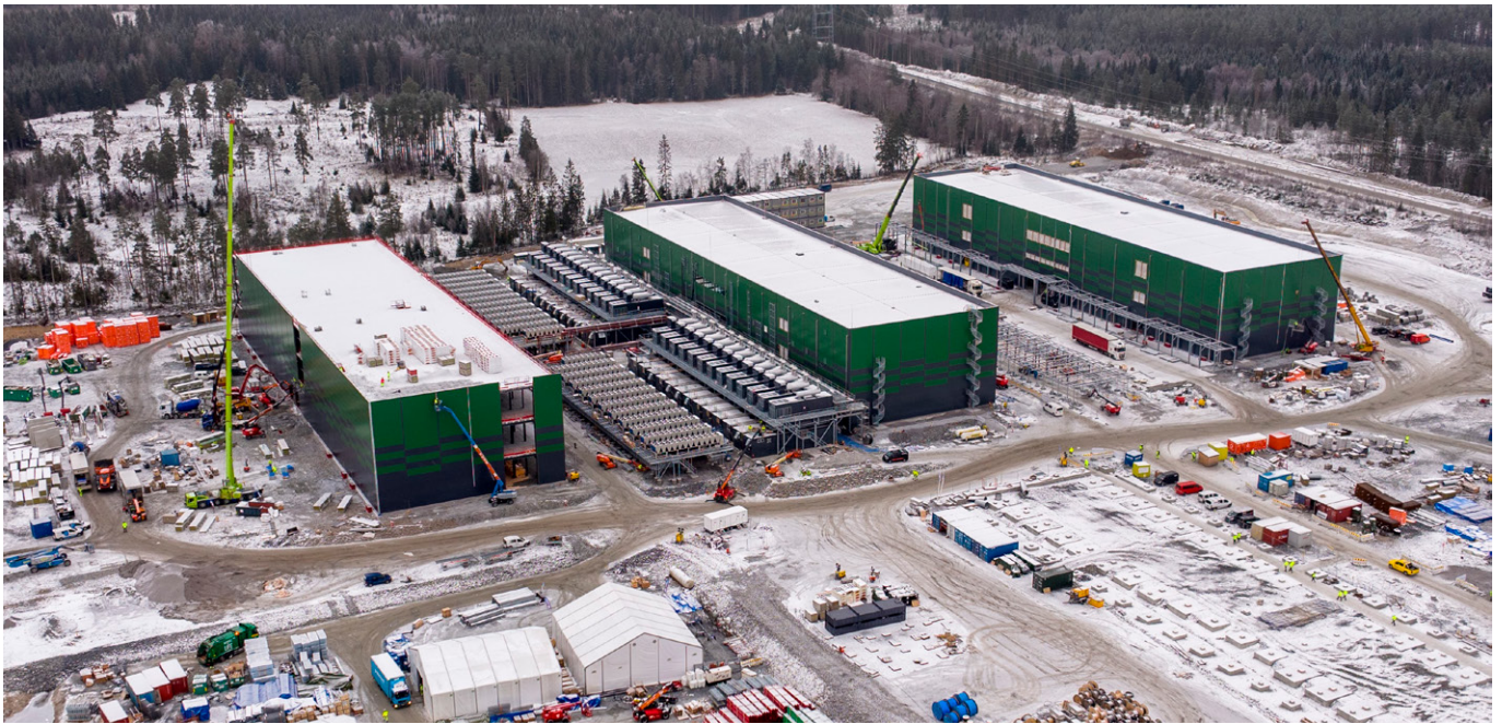
REKORDÅR. Leveranser til datasenteret Green Mountain bygger i Hamar for Tik Tok har bidratt til et rekordår for Elis Elektro. Hallen i midten skal settes i drift i løpet av første halvår i år
