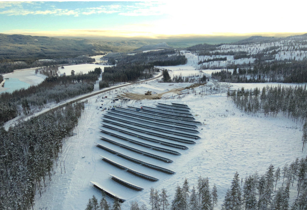
FØRST I NORGE. Furuseth solkraftverk i Stor-Elvdal skal dekke energibehovet til rundt 320 eneboliger
