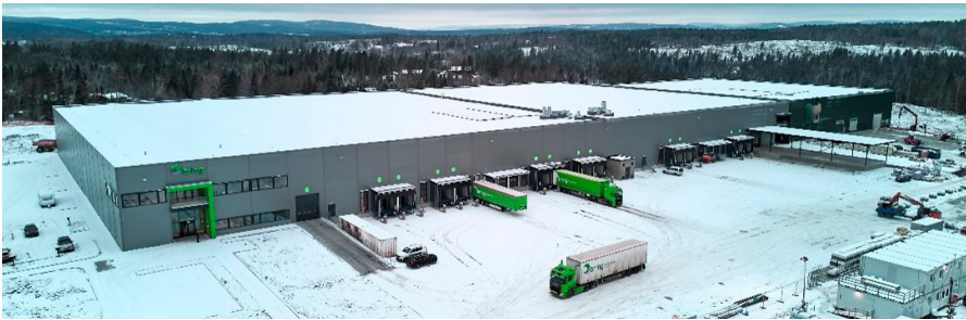
I sitt nye lager i Drøbak har Posten installert et privat 5G-nett
