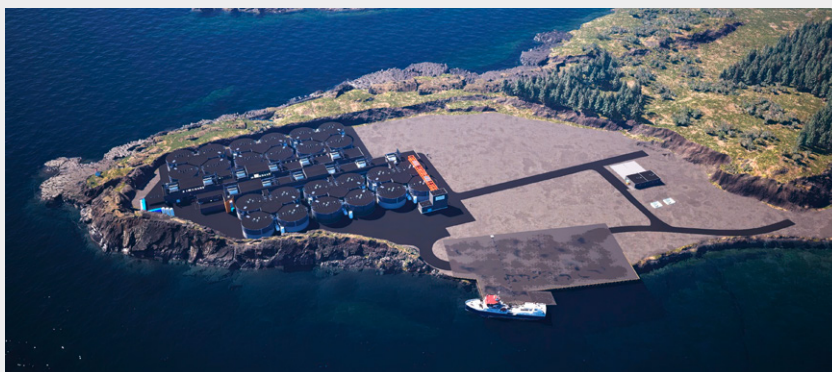
ANDRE BYGGETRINN. Nordkontakt skal automatisere byggetrinn to på det landbaserte oppdrettsanlegget til Salmon Evolution utenfor Molde
