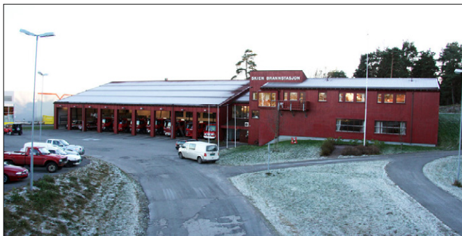
Skien brannstasjon er et av mange kommunale bygg GK skal utføre service og vedlikehold på
