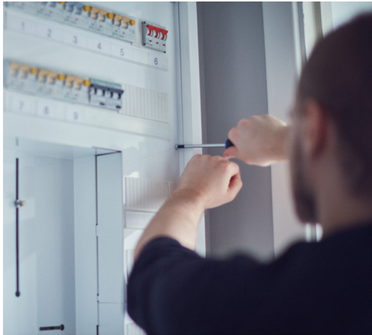
Flere boligeiere sjekker sikringsskapet
