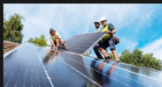
Installasjon av solcelleanlegg på skrå tak
