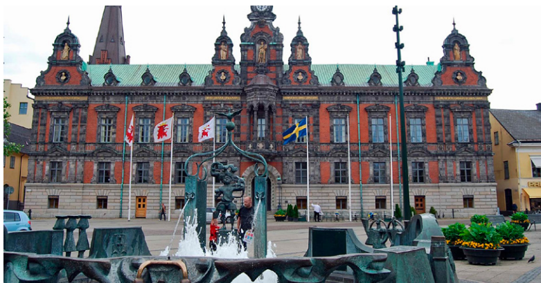
LED-armaturer fra Glamox skal kutte energikostnader, og forbedre innemiljøet på rådhuset i Malmö
