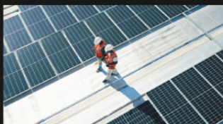
Installasjon av solcelleanlegg på flate tak
